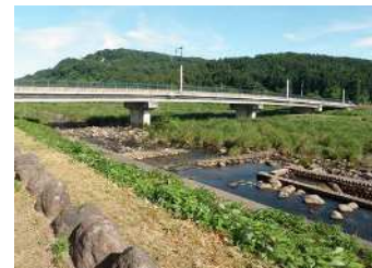
▲文殊1号橋 (橋長 133.5m) 長大橋
