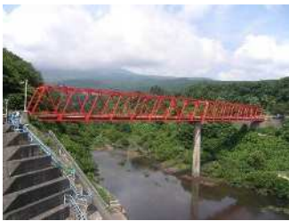
▲月光川大橋 (橋長 135.00m) 孤立橋梁, 特殊橋梁
