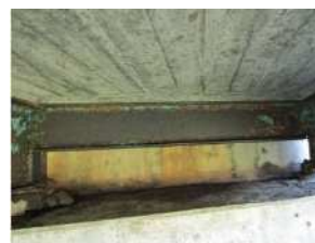
▲横桁の腐食
